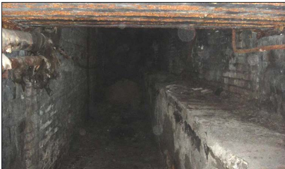
Obr. č. 6 - levostranné rozšíření objektu, zde je lícová strana spodní stavby z betonových cihel. Cihly jsou na povrchu porušené a opadávají, zdivo je vlhké.
