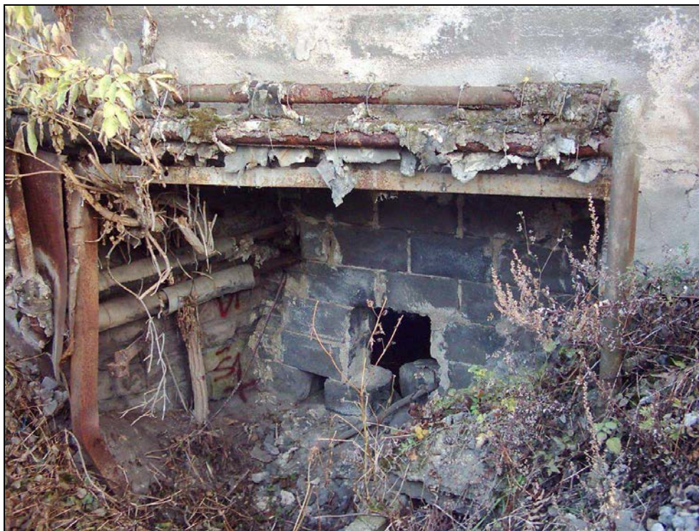
Obr. č. 1 - pohled na objekt zprava, objekt sloužil v minulosti jako technologická spojovací chodba. Vstup z pravé strany je zazděný tvárnicemi.
