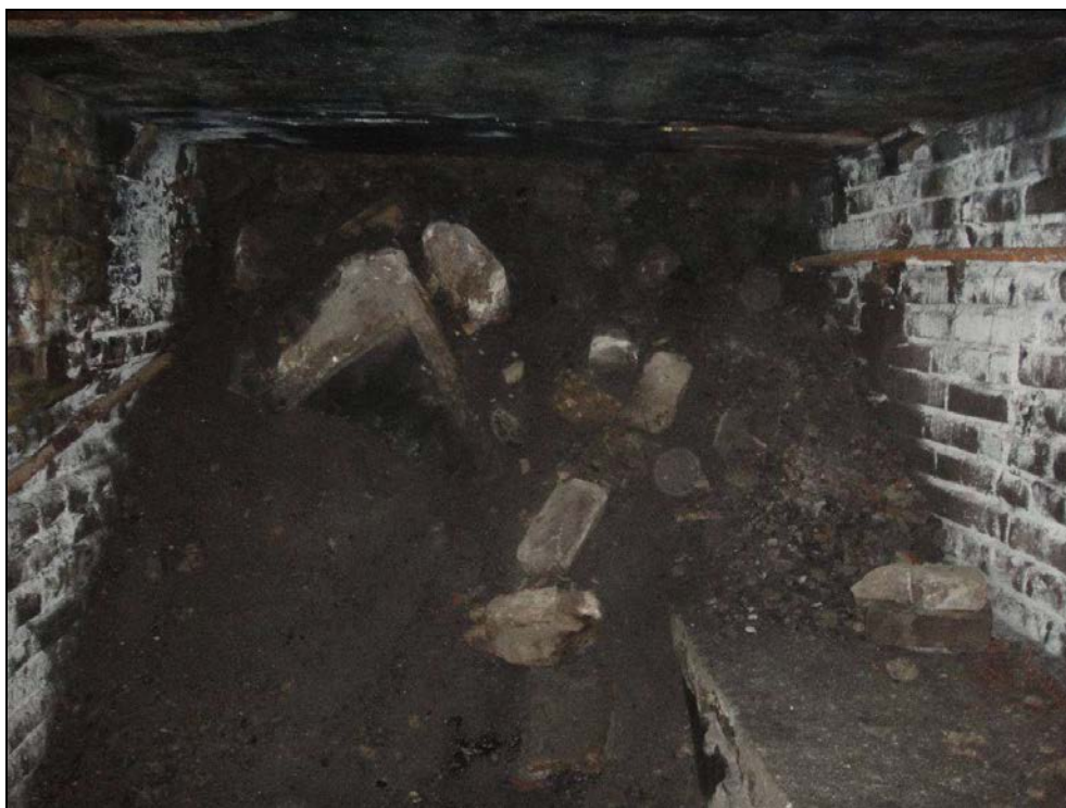
Obr. č. 9 - zasypaní na levé straně propustku, levé čelo je nepřístupné a v terénu není patrné.
