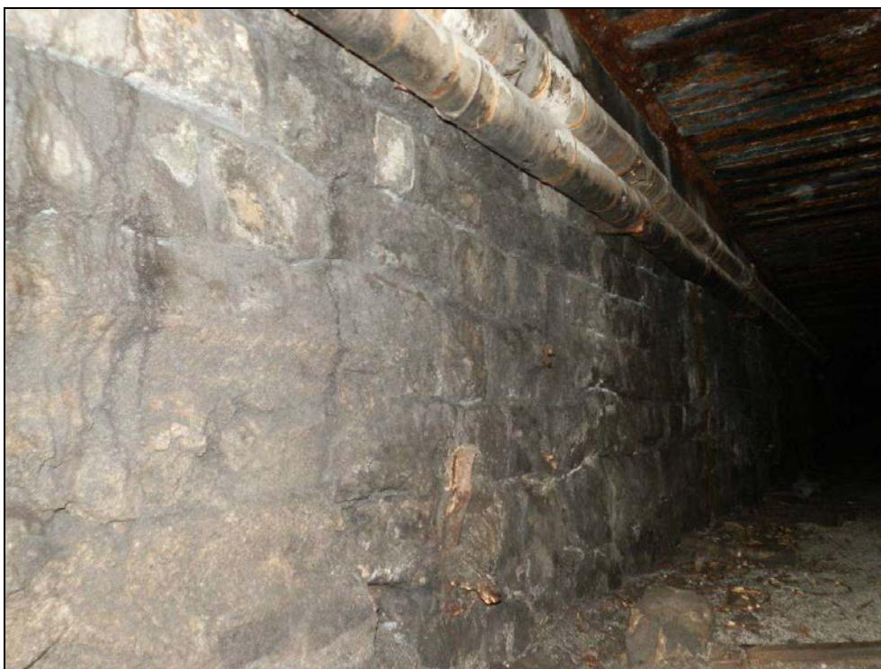
Obr. č. 2 - pohled na opěru Praha pravé původní části. Zdivo je kamenné řádkové.
