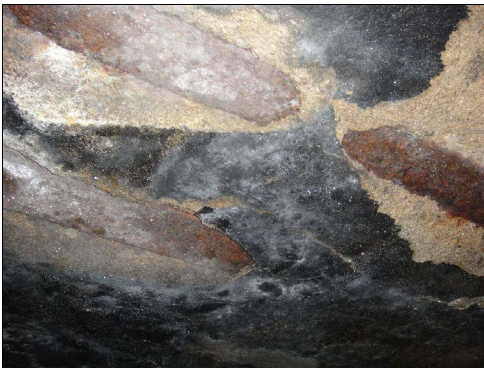
Obr. č. 8 - nosná konstrukce u levostranného rozšíření tvořená zabetonovanými nosníky, krytá zespoda omítkou. Omítka je porušená a často opadává, skrze konstrukci intenzivně zatéká, nosníky jsou s celoplošnou hloubkovou korozí.
